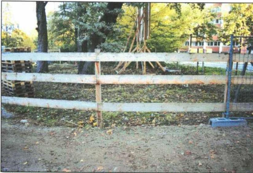
Nicht geeignet sind die metallenen Mobilzäune, da diese – wie der Name schon sagt – mobil sind und sich beim Baubetrieb in der Flächenausdehnung häufig reduzieren und zuweilen ganz entfernt werden. Mit Hilfe der Baumschutzzäune wird der Schutzraum als Tabuzone, d. h. nicht für das Baugeschehen zur Verfügung stehende Fläche, ausgewiesen.
