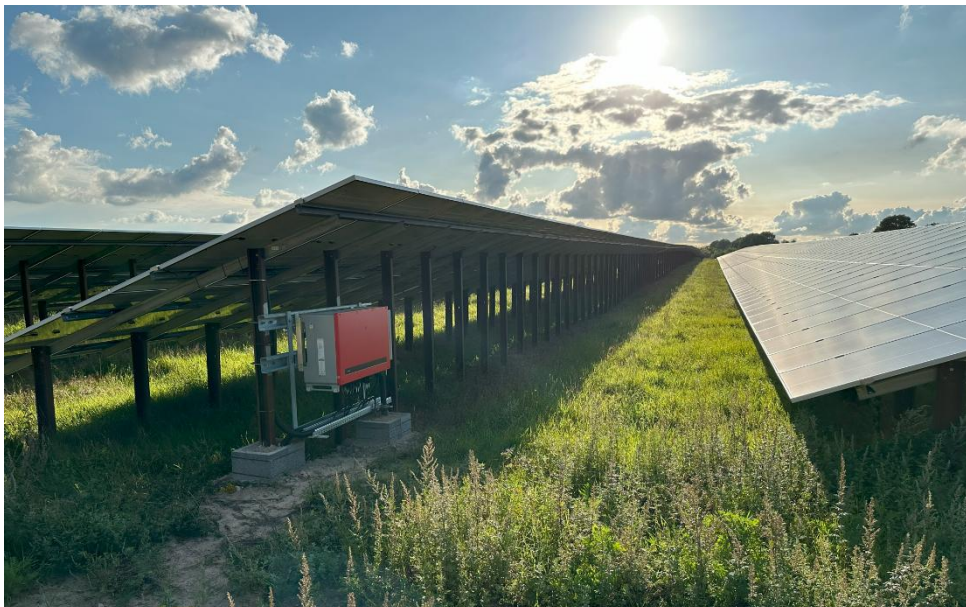
Abbildung 13: Beispiel Modulreihen mit Wechselrichter (Quelle: EE-Plan GmbH)
