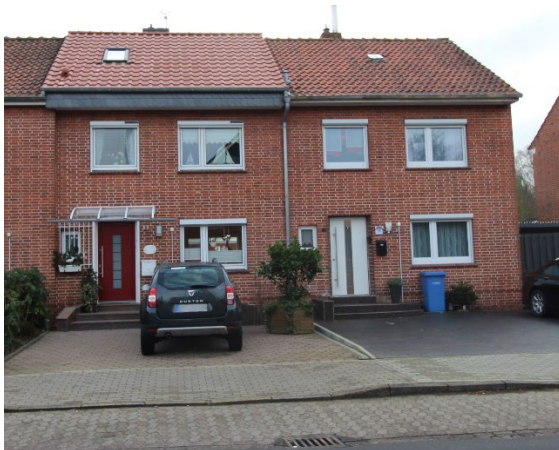
Abbildung 3: Gebäudesanierung in der Pommernstraße
