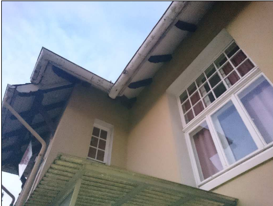
Abbildung 6: Dachvorsprung im südwestlichen Gebäudekomplex
