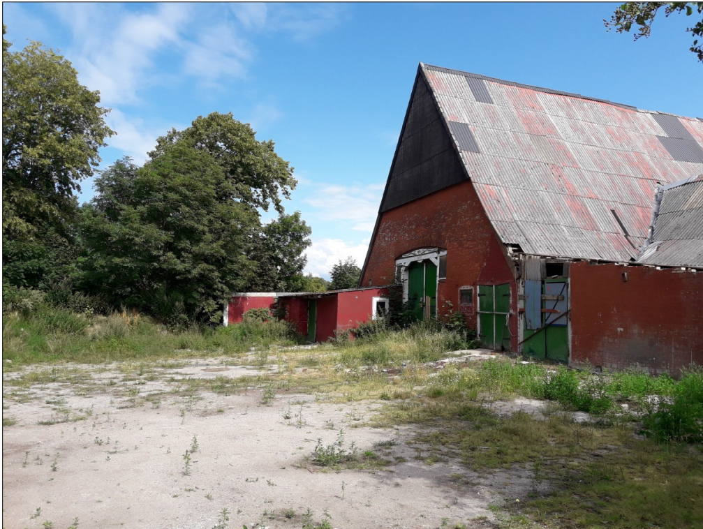
Abbildung 3 Ehemalige Hofstelle Bunde, Blick in Richtung Nordost
