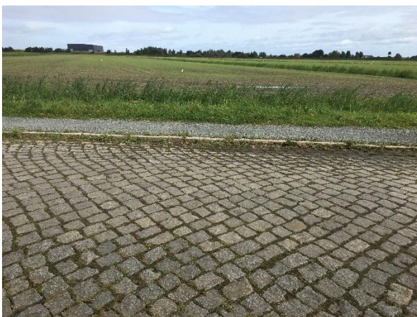
Abb. 15: Die Straße ‚Alte Marsch‘ (OVS) zwischen Altenbruch und Groden
